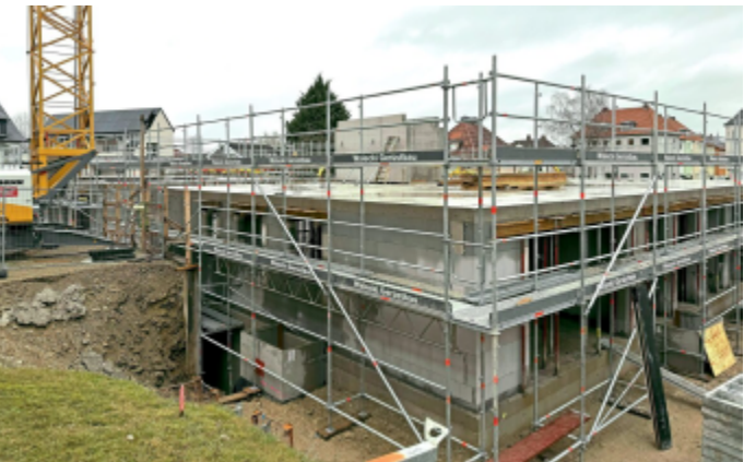
Der Baufortschritt im Klimaquartier ist bereits deutlich sichtbar. Hier ist eines der drei Stadthäuser im hinteren Teil des Grundstücks zu sehen.
