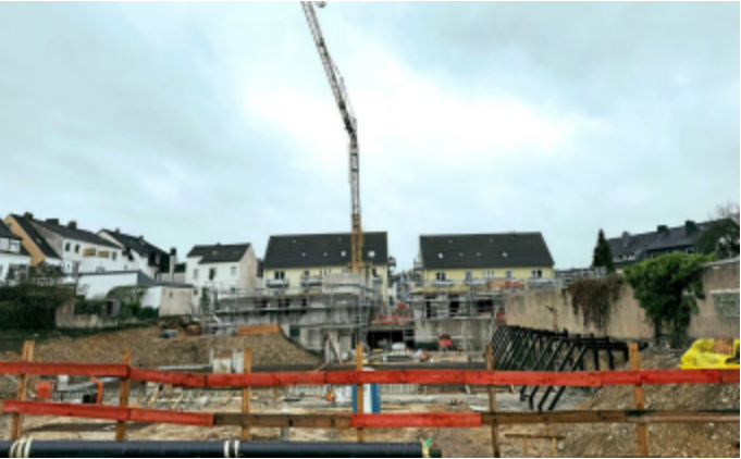
Was für ein großes Bauloch! Rechts musste ein Gebäude auf dem Nachbargrundstück vorsorglich mit Eisenträgern abgestützt werden.
