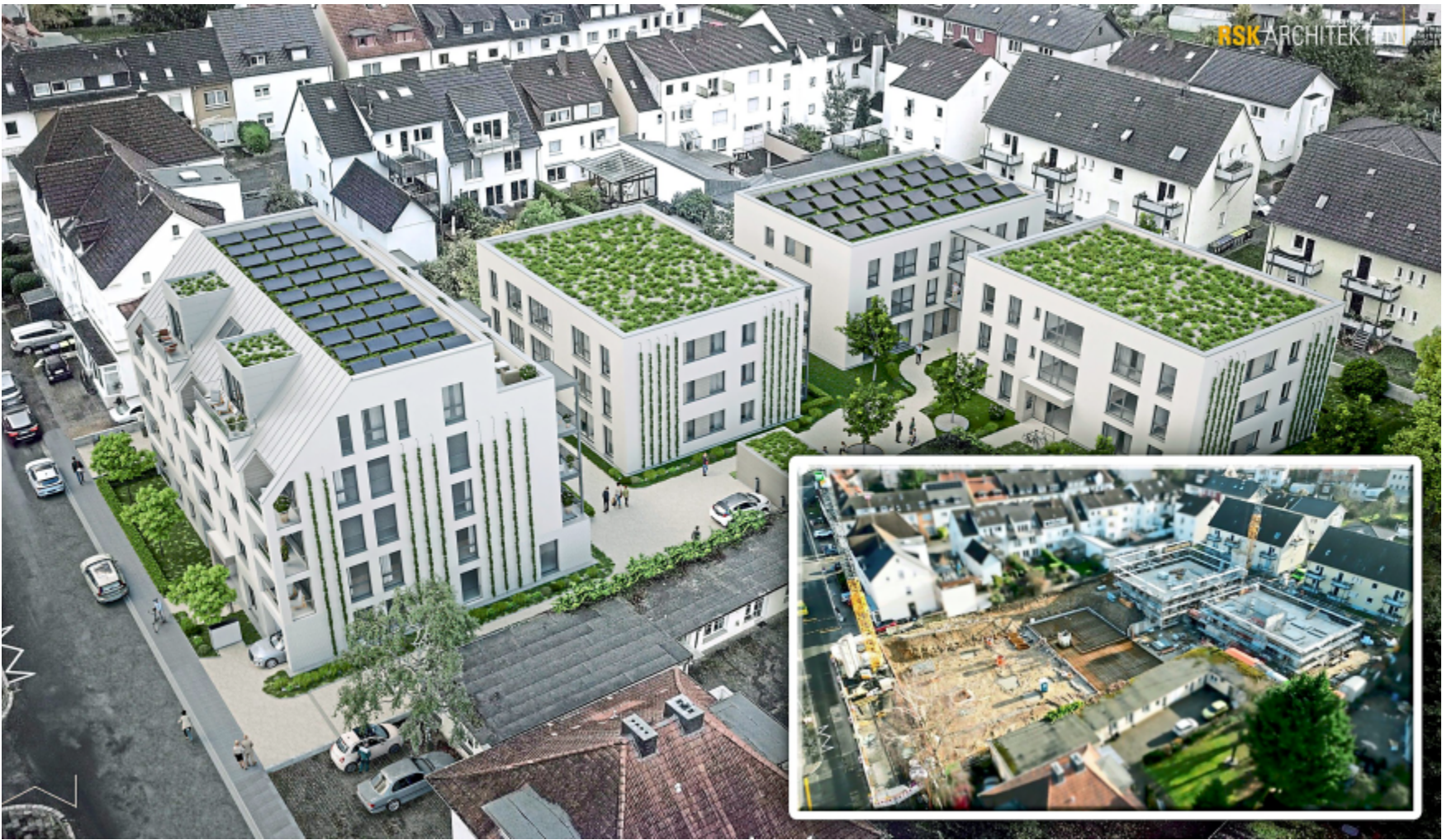
Das Projekt des Spar- und Bauvereins am Querweg (Straße links im Bild) macht Fortschritte. Vier neue Gebäude entstehen hier, vorn an der Straße wird das Haupthaus mit den Inklusions-Appartements errichtet, dahinter werden drei Stadthäuser mit je neun Wohnungen gebaut. Im März 2027 sollen die Häuser bezugsfertig sein. Fotos: Brockmeyer Architekten/Spar- und Bauverein
