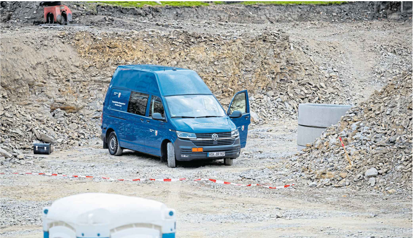
An der Baustelle am Querweg ist der Kampfmittelbeseitigungsdienst im Einsatz gewesen.
