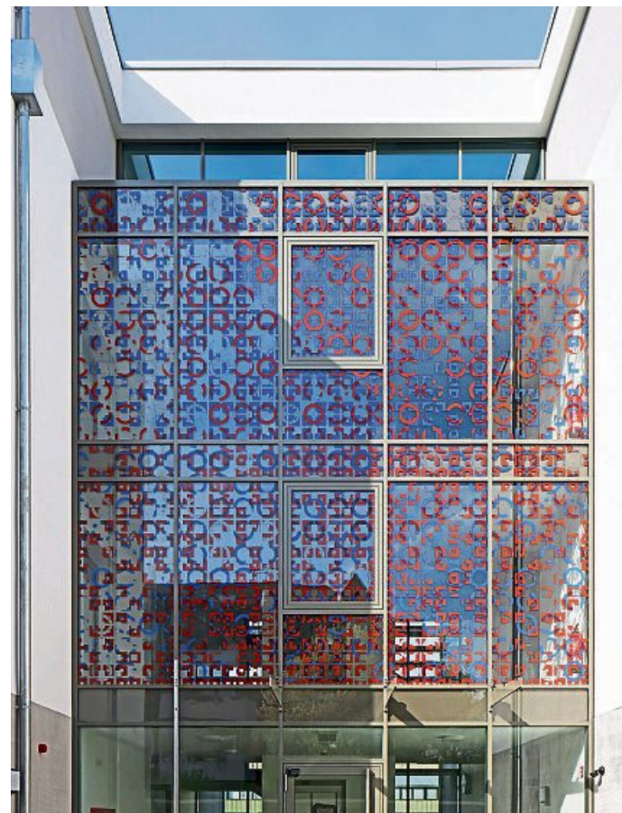
Optischer Hingucker ist die gläserne Treppenhauseinfassade zwischen den beiden versetzten Gebäudeteilen. Foto: Dietmar Flach
