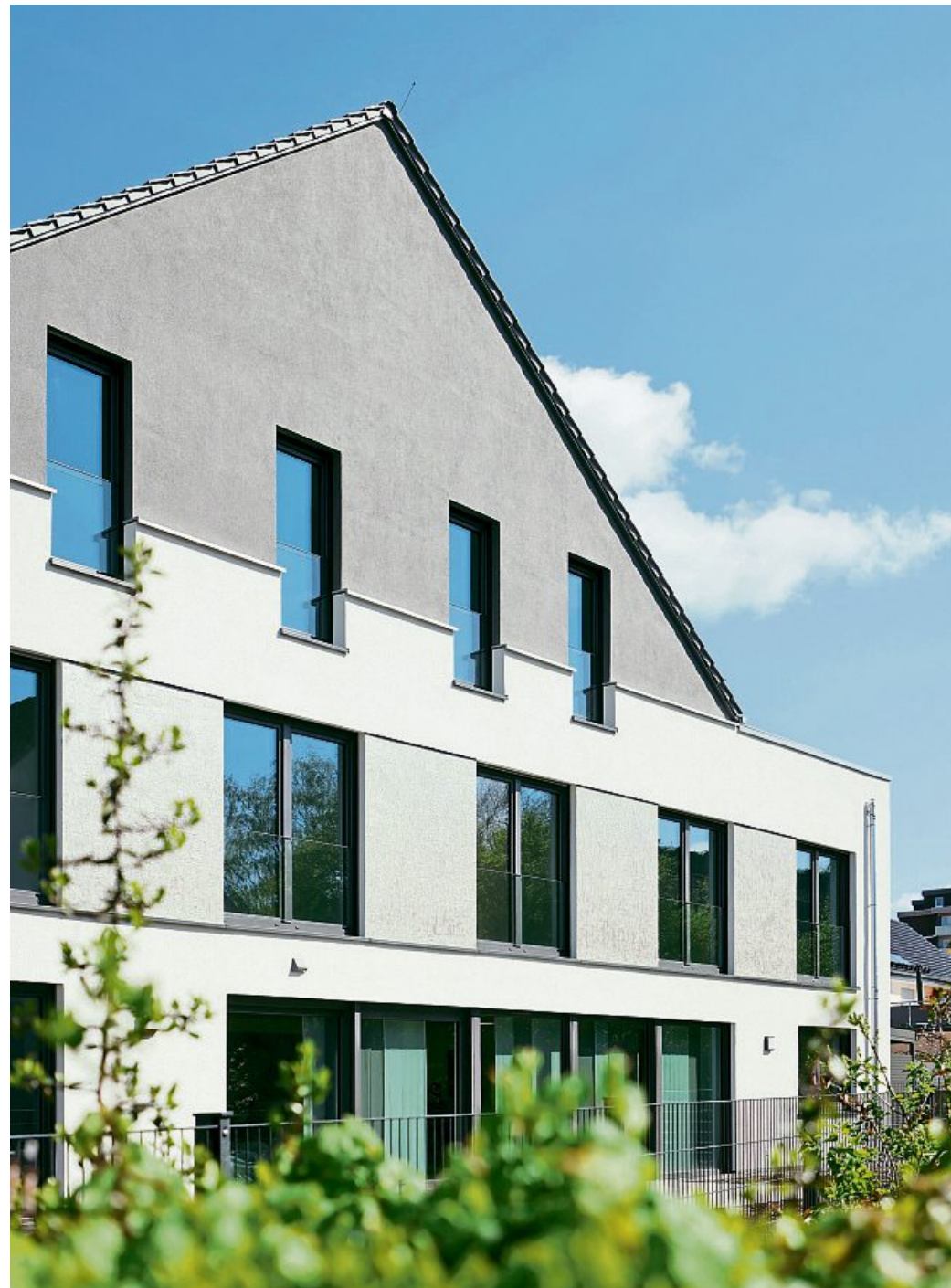
An der Kunigundenstraße ist ein Baukörper mit zwei Vollgeschossen und einem ausgebauten Dachgeschoss entstanden Foto: Dietmar Flach
