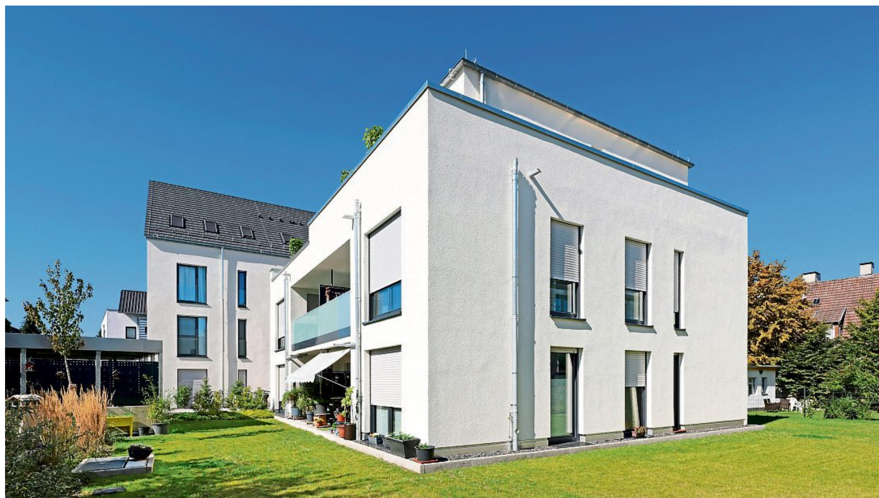
Durch den Erwerb des 701 Quadratmeter großen Nachbargrundstücks Sturmiusstraße 11 entwickelte sich an dieser sehr exponierten, innerstädtischen Fläche auf 1.283 Quadratmetern eine interessante Entwicklungsperspektive.
