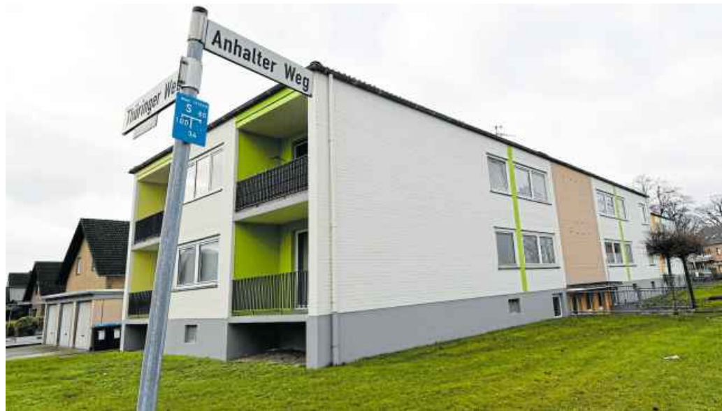
Das Mehrparteienhaus soll für den Neubau abgerissen werden. Die bisherigen Mieter hätten bereits neue Wohnungen gefunden.
