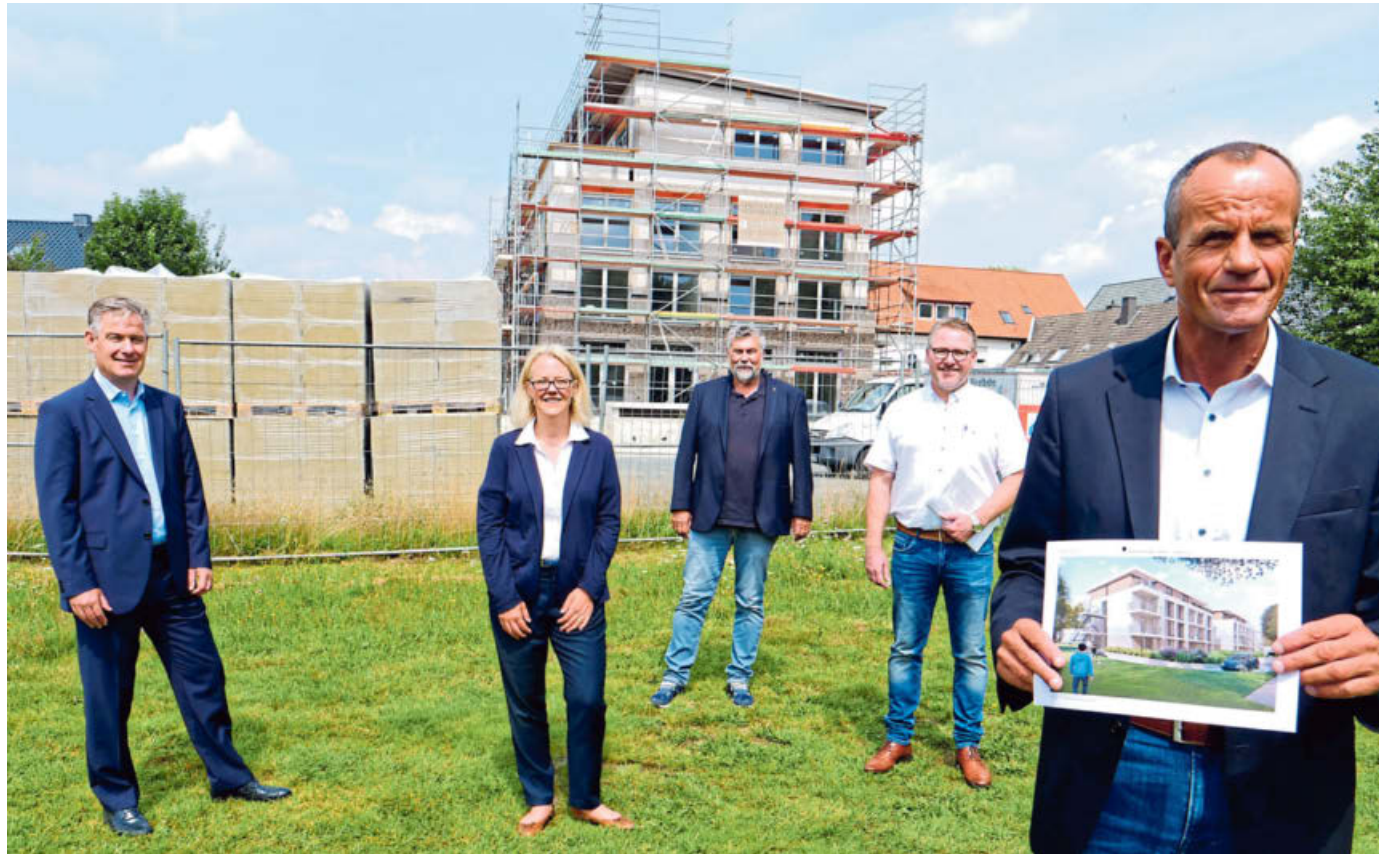
Mit einer Ansicht des Wohnprojektes: Thorsten Mertens (r.), Vorstandssprecher des Spar- und Bauvereins Paderborn, und (v. l.) Bürgermeister Michael Berens, Sandra Waters und Michael Hülsmann, Bethel Regional, und Wirtschaftsförderer Thomas Westhof stellen die Planung vor. Im Hintergrund der Neubau des Deutschen Roten Kreuzes. Foto: Ralph Meyer
